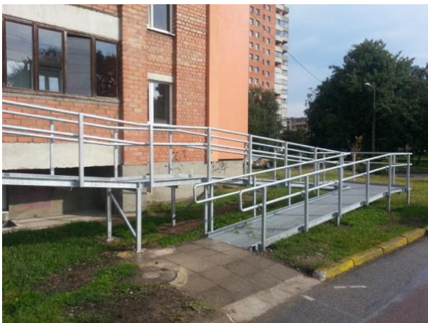
Tammsaare 141a nõuetekohane metallkonstruktsioon pandus.
