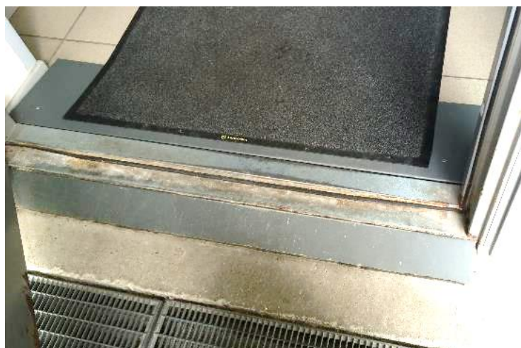
Korterelamu tasandusplekid paigaldatuna mõlemal pool läve, kummist alusega porimatt ja liikumist mittetakistav porirest.
