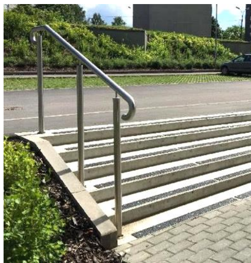
Tallinna sotsiaalameti ametikäigu astmete kontrastne ja mittelibisevate (karedate) ribadega tähistamine. Välistrepp libisemisvastaste ja kontrastsete ribadega Vana-Keldrimäe tänaval.
